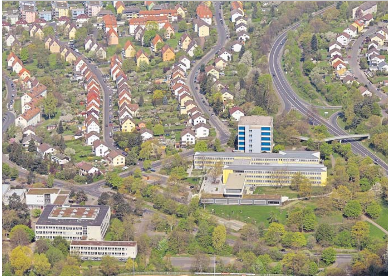
Immer wieder musste die Richard-Müller-Schule in den vergangenen Jahrzehnten erweitert werden. Der moderne Teil ganz vorne, teils wirkt, entstand von 2009 bis 2012. Links ist das Domgymnasium zu sehen, rechts das Sportbad Ziehers und die angrenzende
